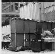
Dozowanie paliw alternatywnych (biomasy)
